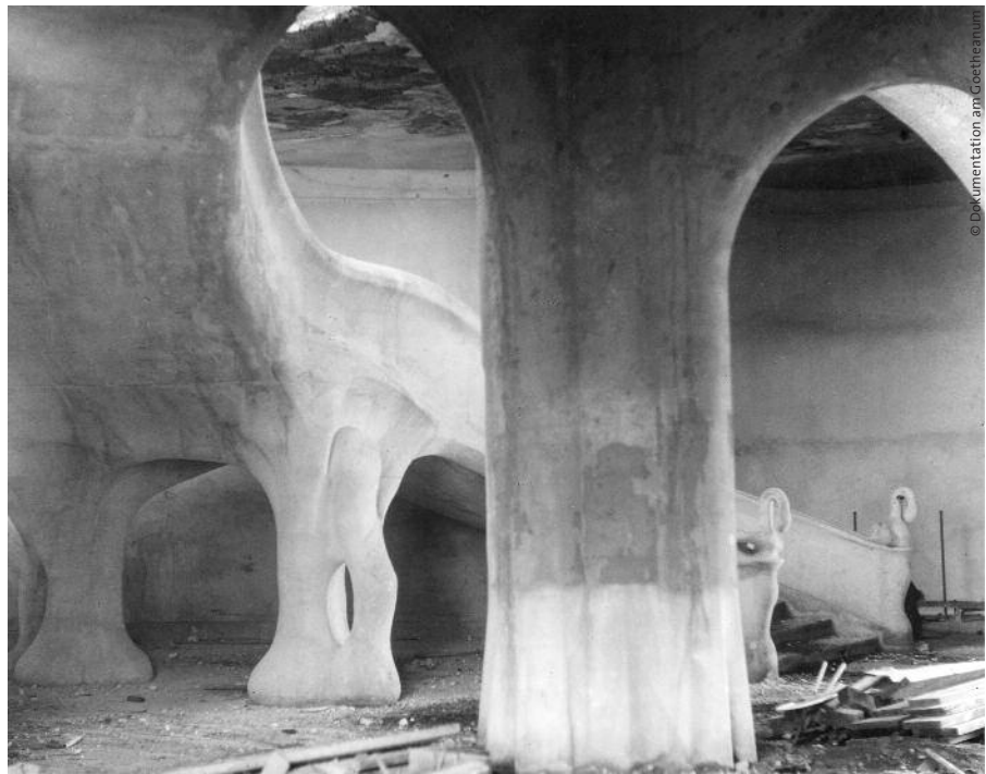
In historischen Kontext stellen: Das erste Goetheanum, Treppenhaus, 1921
